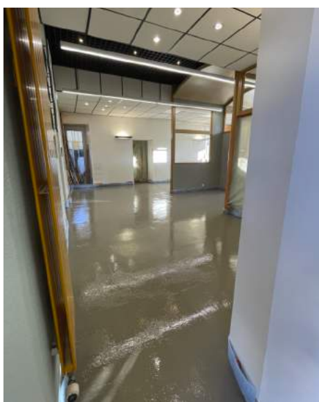
Les travaux de rénovation de l'accueil de la Mairie avancent à grands pas. La nouvelle dalle a été coulée. En attendant le carlage.
