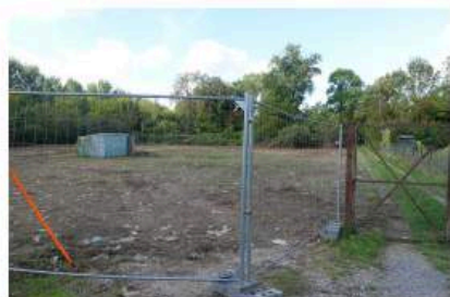
En attente de démolition (Parcelle N°1)
