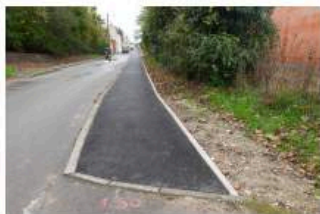
Réfection du trottoir
