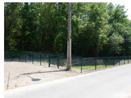
Clôture du bassin
