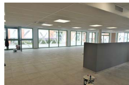
Salle de restaurant
