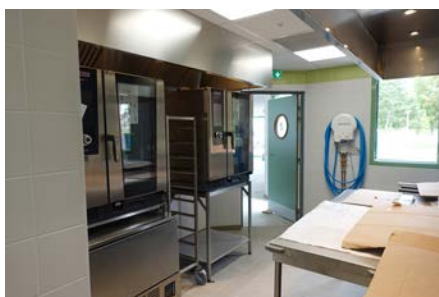
Cuisine en cours d'aménagement
