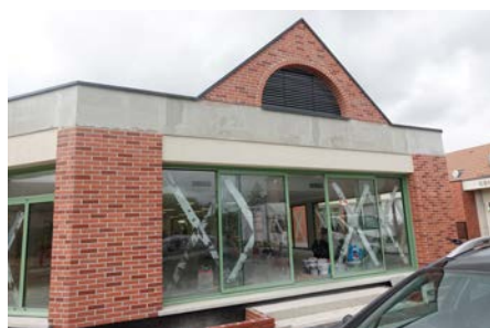
Extension vue extérieure
